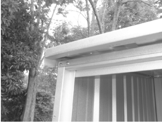
CORNER DOOR JAMB ASSEMBLY
